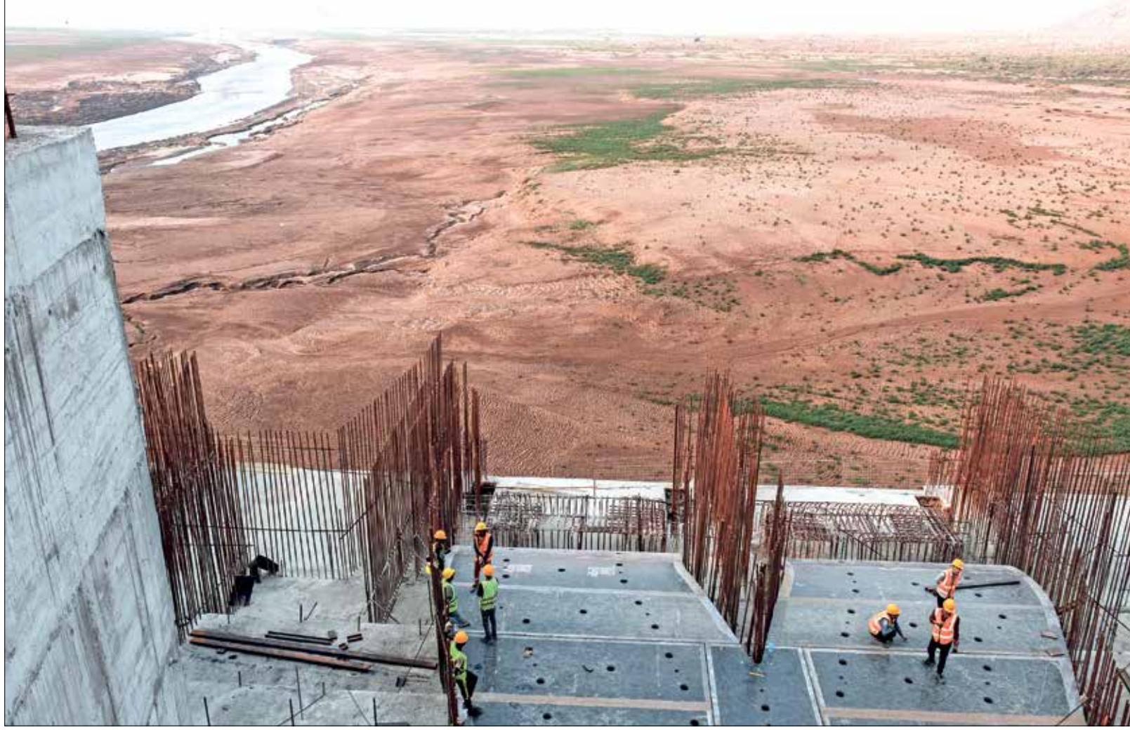
من أعمال البناء في سد النهضة الإثيوبي في 26 /12 /2019 (فرانس برس)
